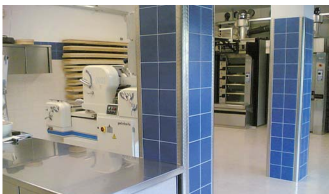
Esempio di posa paraspigolo raggiato - Dis. N° 1001
