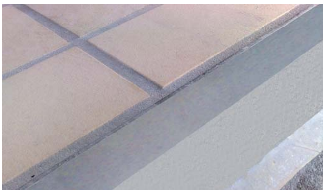
Esempio di posa paraspigolo terminale - Dis. N° 1004
