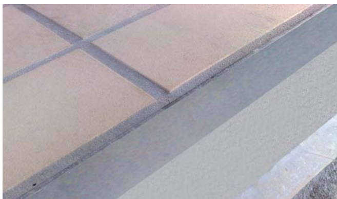
Beispiel einer Installation eines End-Eckschutzprofils - Zchg. N° 1004
