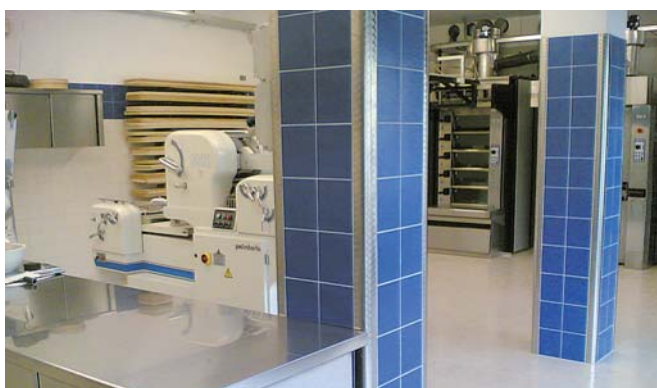
Beispiel einer Installation einer abgerundeten Kantenabdeckung - Zchg. N° 1001
