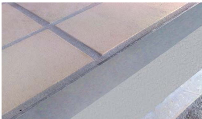
Beispiel einer Installation eines End-Eckschutzprofils - Zchg. N° 1004
