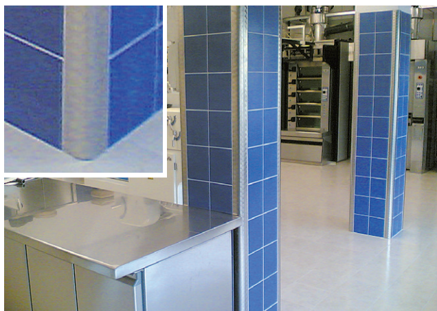
Esempio di posa para spigolo raggato - Dis. N° 1001
