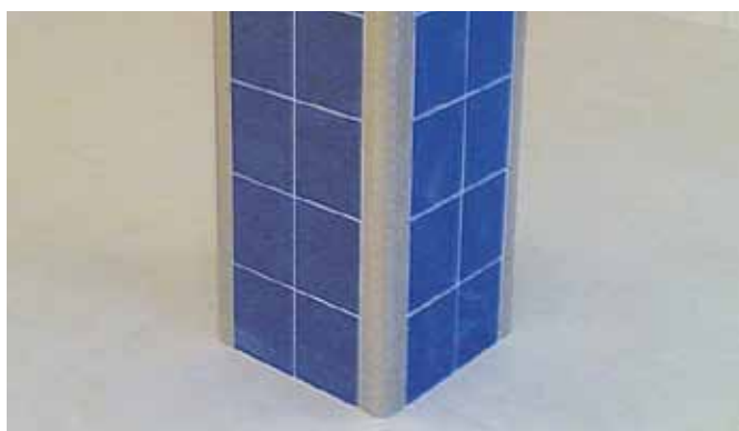
Exemple de profilé de protection arrondis - Dess. N° 1001
