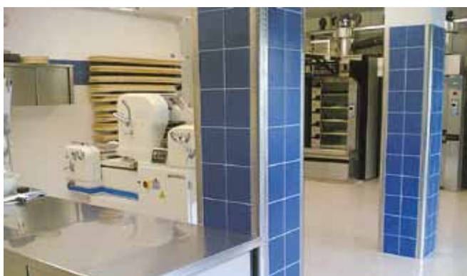
Exemple de mis en oeuvre du profilé de protection arrondis - Dess. N° 1001
